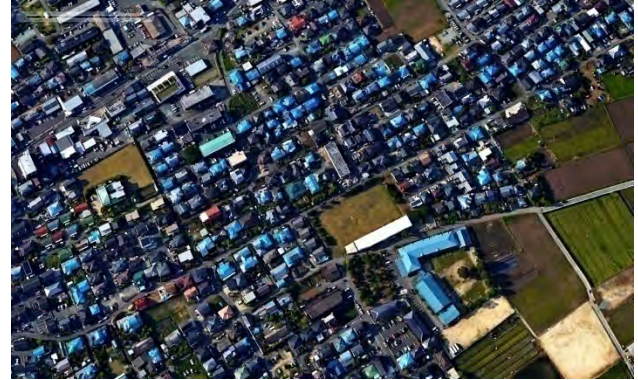
図 24 益城町のブルーシート状況
