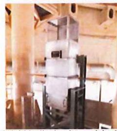
静的触媒式水素再結合装置
