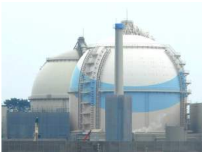
対岸の串地区から見える3・4号機
